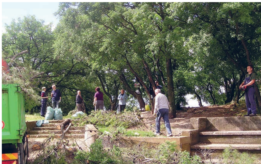
Radovi na trim stazi
