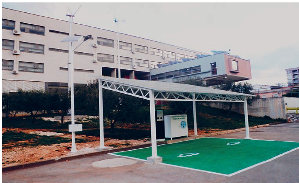
Solarna punionica
