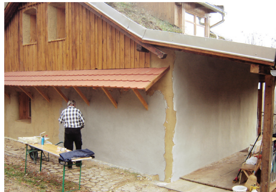
Slika109. Žbukanje treće „ruke“ vapnom
