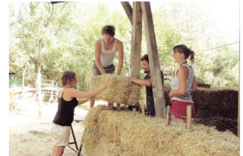
Slika 87. Gradnja zida od bala slame
