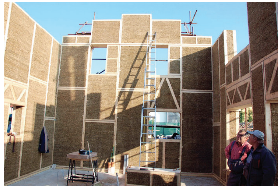
Slika 13. Gradnja predgotovljenim elementima od slame, Hitzendorf, Austrija
