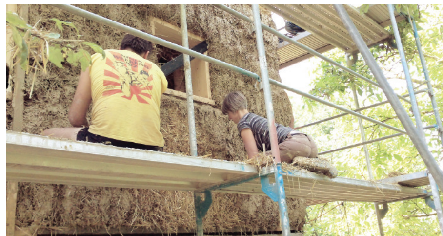
Slika 105. (gore) Nanošenje glinenog predloja/podžbuke
