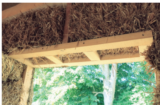
Slika 99. prozorska potkonstrukcija od letvi
