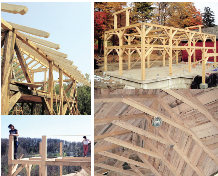
Slike 76,77,78. Drvena konstrukcija
