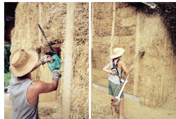
Slike 95, 96. Ravnanje zida od slame električnim škarama za živicu i trimerom
