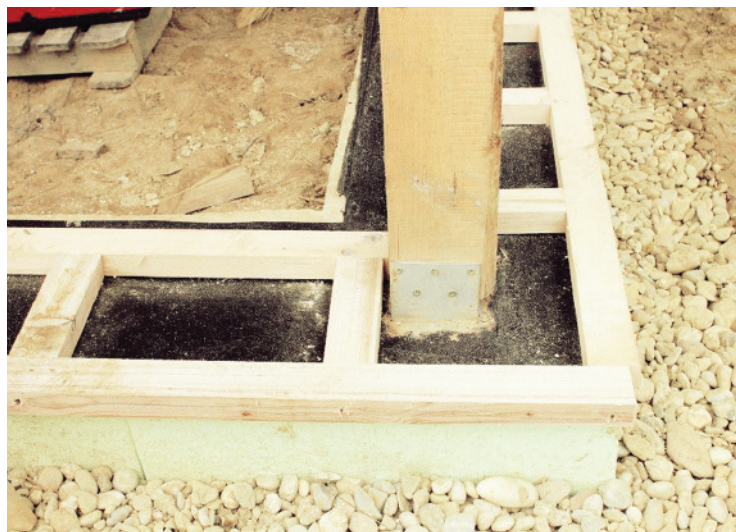
Slika 74. Spoj temelja, konstrukcije i bala slame.
