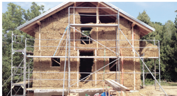
Slika 94. Ojačanja okomitim drvenim letvama - na kutevima i kod otvora
