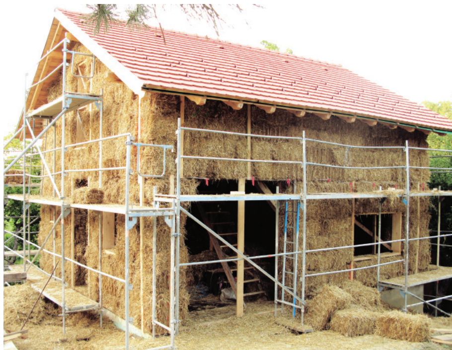
Slika 101. Kuća od bala slame prije žbukanja
