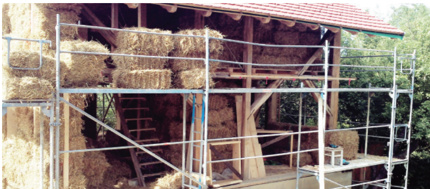
Slika 90. Postavljanje bala slame
