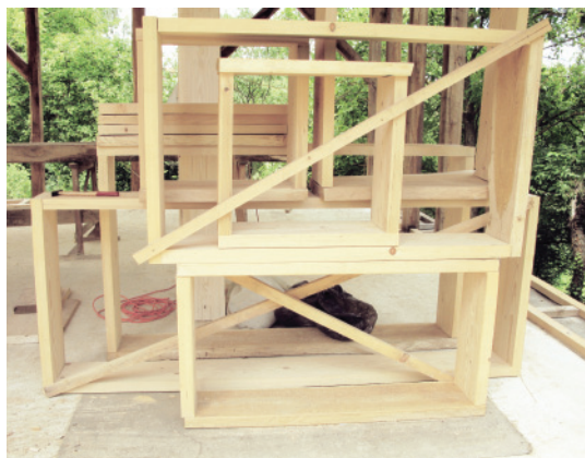
Slika 98. Pripremljene kutije prozora i vrata
