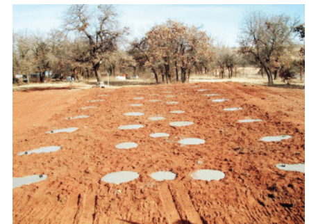
Slika 66. Točkasti temelj
