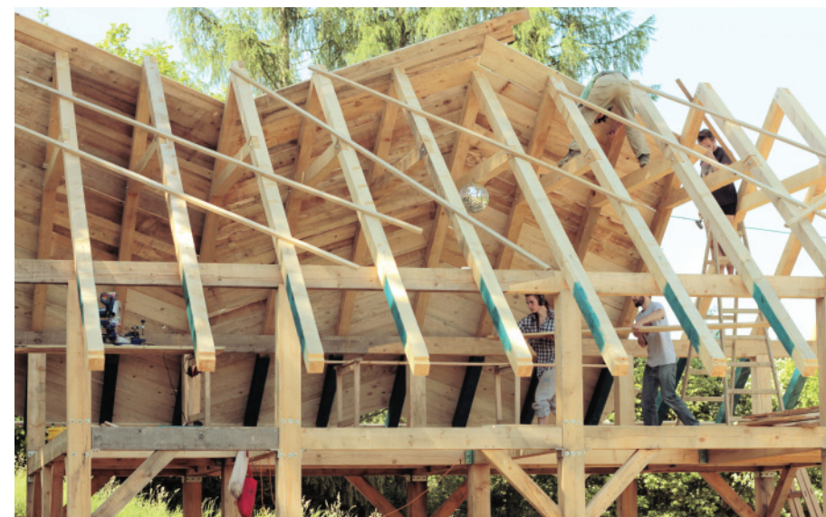
Slika 80. Drveno krovište u izgradnji
