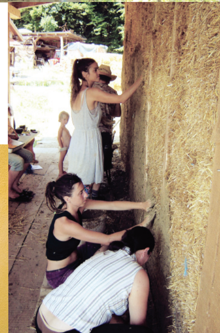
Slika 105. (gore) Nanošenje glinenog predloja/podžbuke
