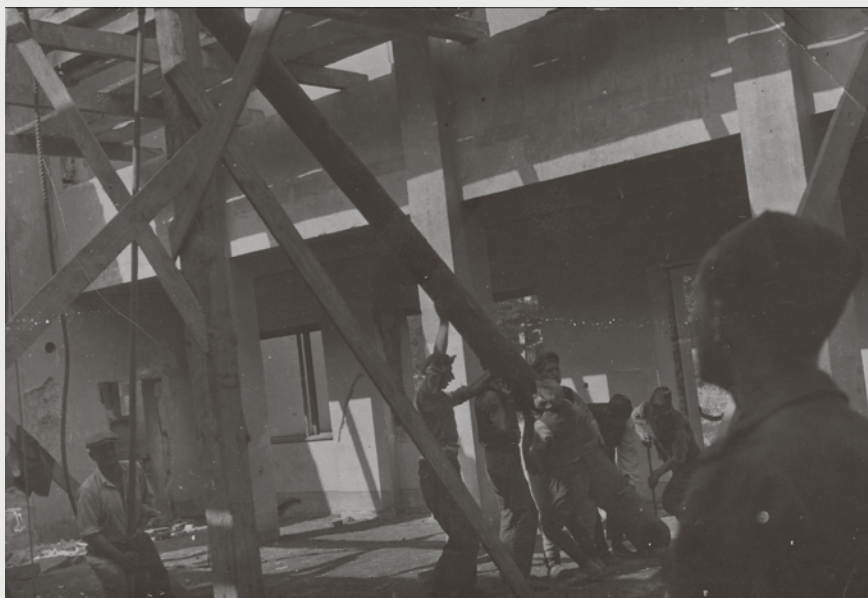
★ I-46: Obnova zgrade Sokolskog doma u Jajcu 1943. godine.
